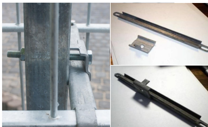
4. Gabiona sienas stiprināmas pie staba sāna ar U profilu/stabilizatoru. Stabā iebj caurumu un piestiprina stabilizatoru, izmantojot speciālu skavu un M8 skrūvi.
