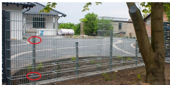
Profilus/stabilizatorus vajadzētu uzmontēt staba apakšpusē un augšpusē (stiprinot pie priekšpēdējā horizontālā gabiona šķērsstieņa. Ja gabions ir līdz 60 cm augsts, pietiek tikai ar apakšējo profilu/stabilizatoru.
