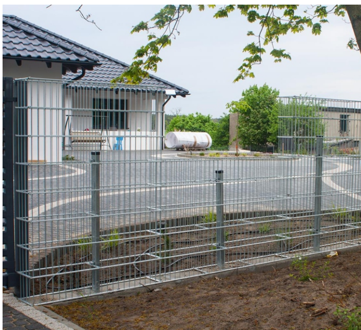
3. Uz sagatavotā pamata uzmontē gabiona kasti.
